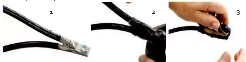
Figura. 3 Un buen método de aislamiento de conexiones permite un fácil retiro futuro
