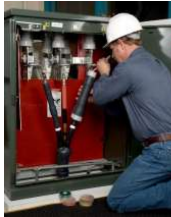
Figura. 6 Conexión de motores en MT
