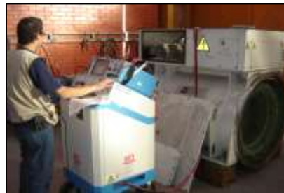
Figura 3 Ejecución de prueba de impulso y reporte (Fuente: cortesía de Ferroman, Chile)
