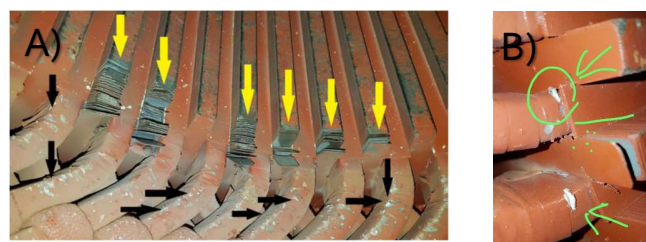
Figura 2. Vistas del estator: A) Chapas finales sueltas, B) Daño producido en fase N°3 (Cortesía de Ferroman S.A., Chile)
