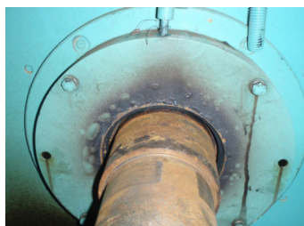
Rodamiento con falla
