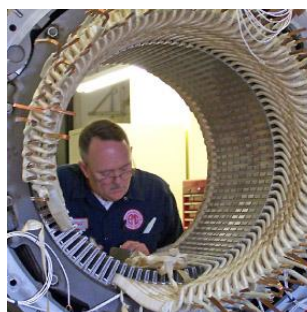
Fig. 6 Proceso de colocación de sensores en el bobinado
